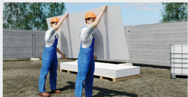
Hardie® Fassadenplatten sind immer hochkant zu tragen
