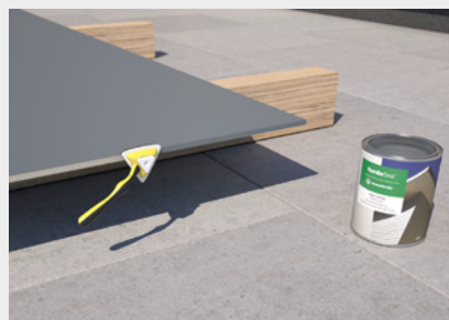
Auftragen der Kantenversiegelung vor der Montage.
