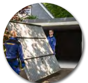
Ausbau und umwelt- gerechte Entsorgung
